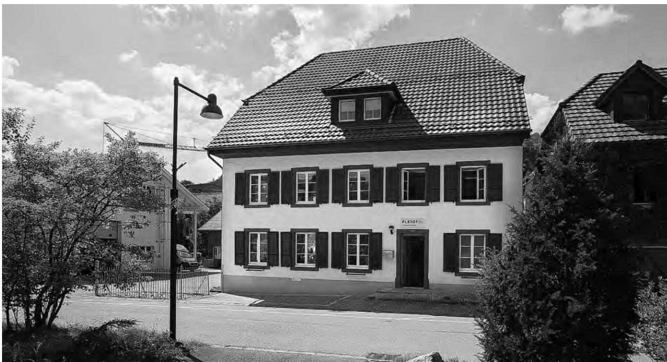
Flexor Verwaltungsgebäude Bärenwilerstrasse 10
